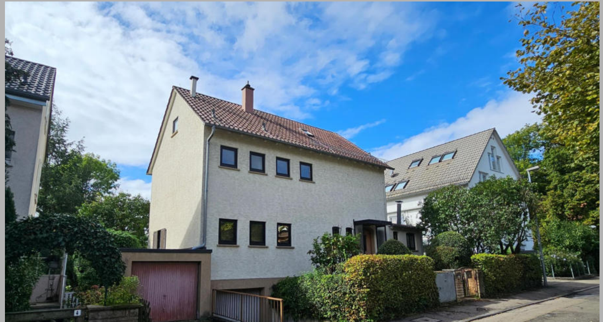
Grundstück mit Abrissgebäude
