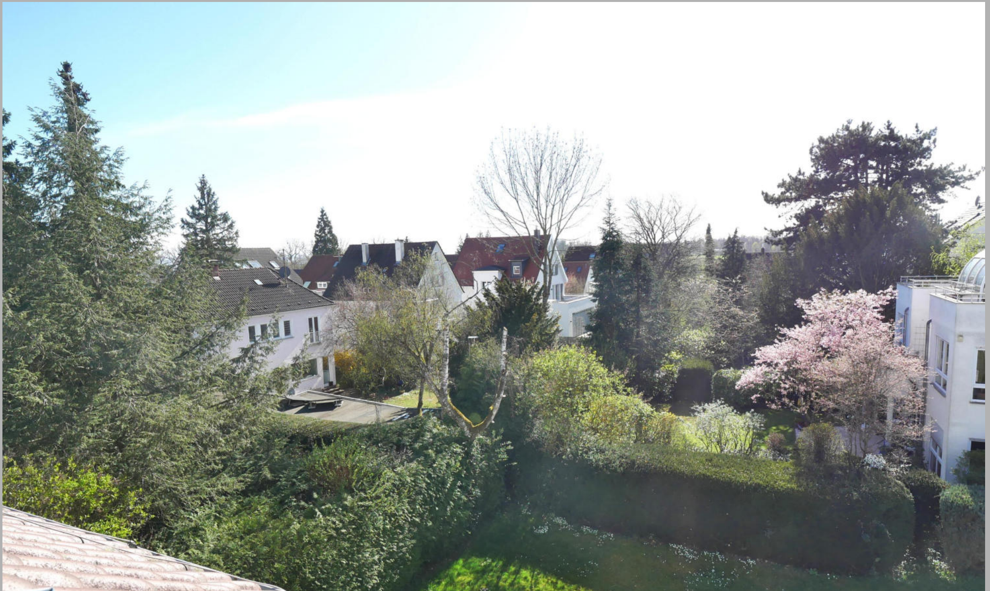
Blick vom Abrissgebäude in die Nachbargärten
