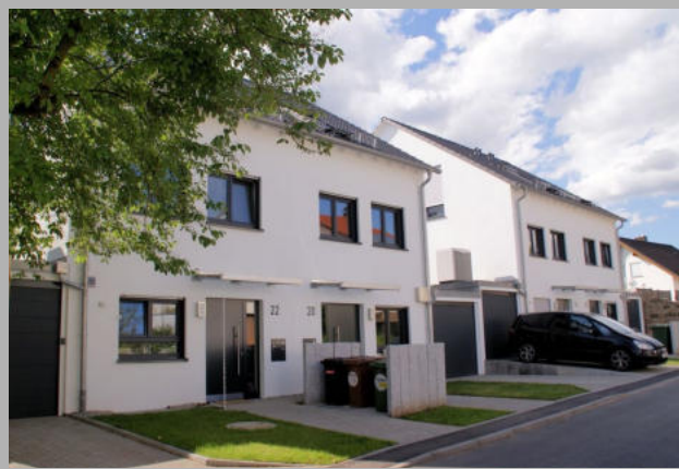
S-Birkach, Bientzlestr. 16 - 22 (4 Doppelhaushälften, BJ 2013)
