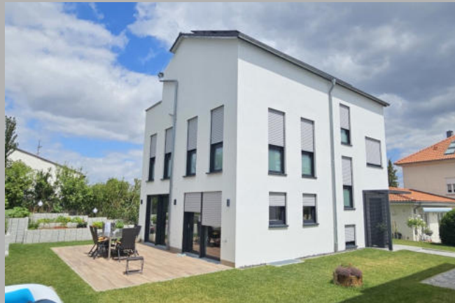
S-Feuerbach, Hohewartstr. 162 B (Einfamilienhaus, BJ 2023)
